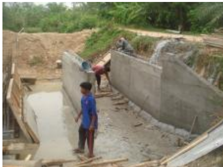
ก่อสร้างท่อเหลี่ยมคสล. คลองห้วยซ้อย
