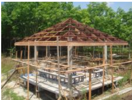
ก่อสร้างศาลาริมทาง
