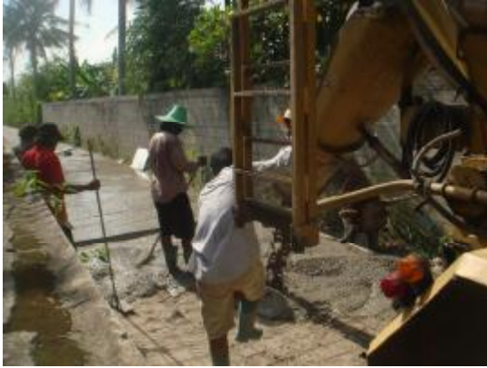
3. ปรับปรุงถนนบ้านนาอ้าย
